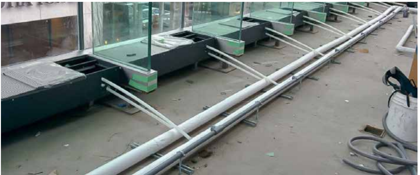
Clima Canal: Installatie
