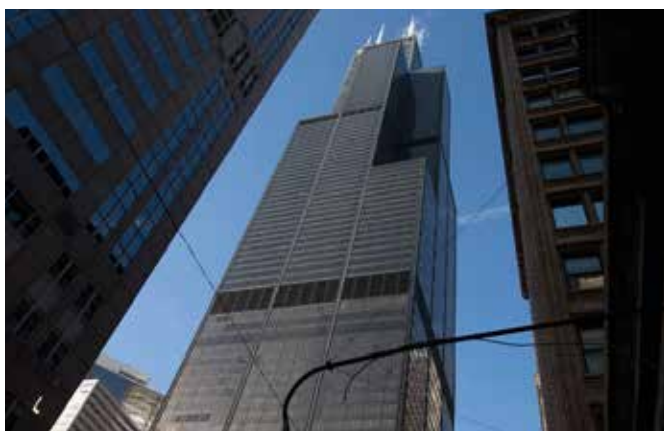
Willis Tower - USA - Clima Canal
