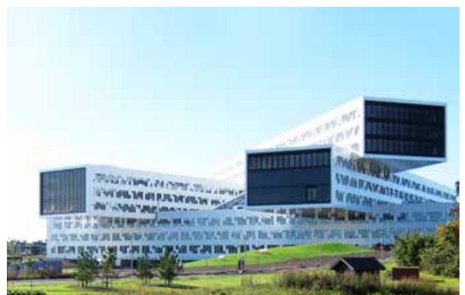
Statoil HQ - Norway - Mini Canal
