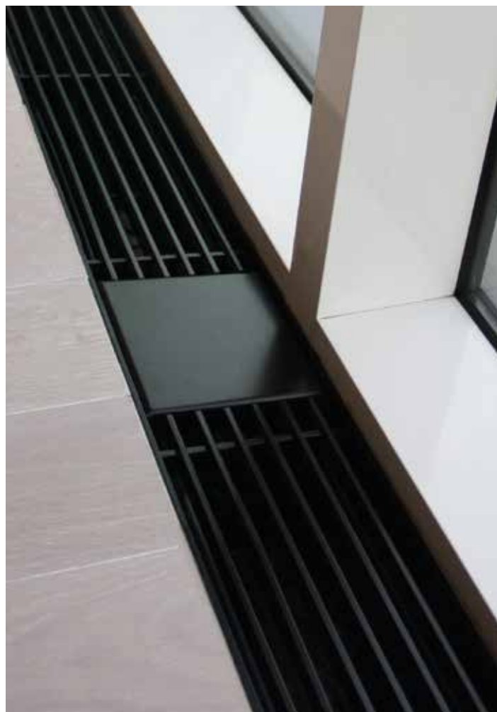
Mini Canal modulo de tabique intermedio con aislante acústico (aislamiento no suministrado) Espace Seine - Francia
