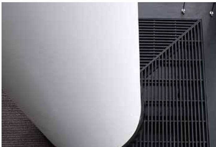
Mini Canal rooster met cirkelvormige uitsnijding Santander Bank - Mönchengladbach
