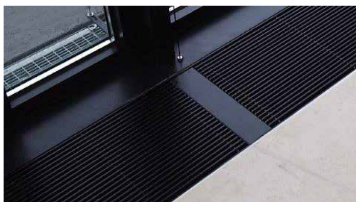
Mini Canal isolierend tussenschot Santander Bank - Mönchengladbach
