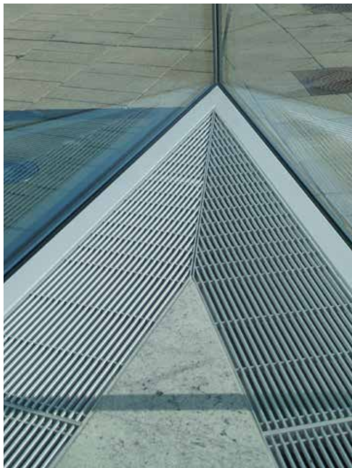
Mini Canal fabricación de esquinas a medida (Rejillas rígidas de aluminio) Aller Media Building - Copenhagen Dinamarca
