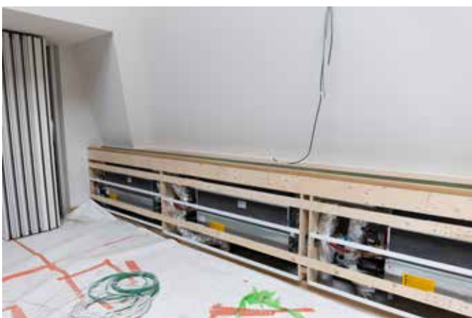
Installation i en vægdsparing
