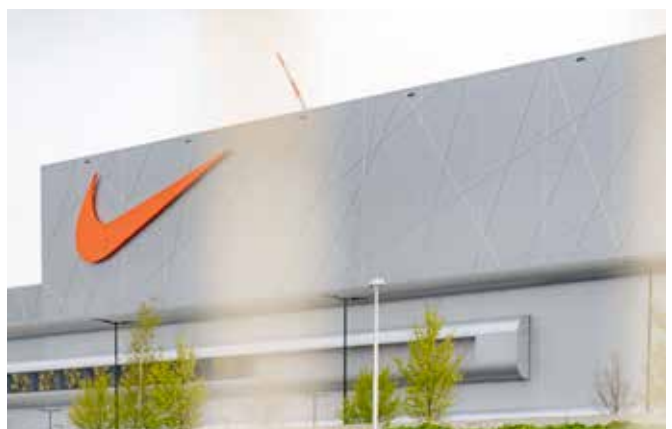
Nike Distributiecentrum - Belgien - AVS Unit heater
