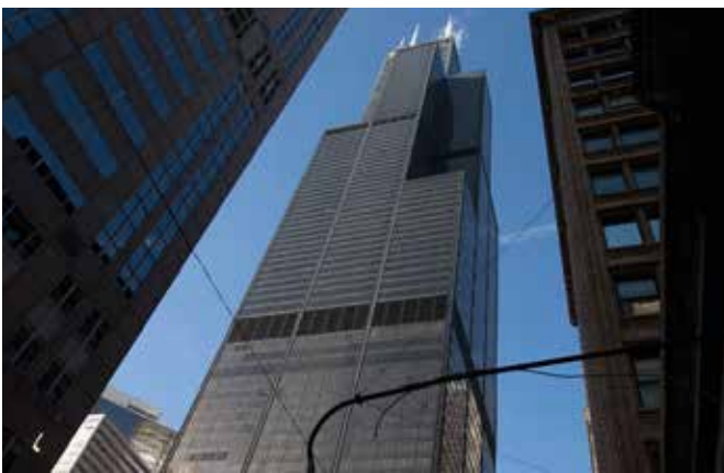
Willis Tower - USA - Clima Canal
