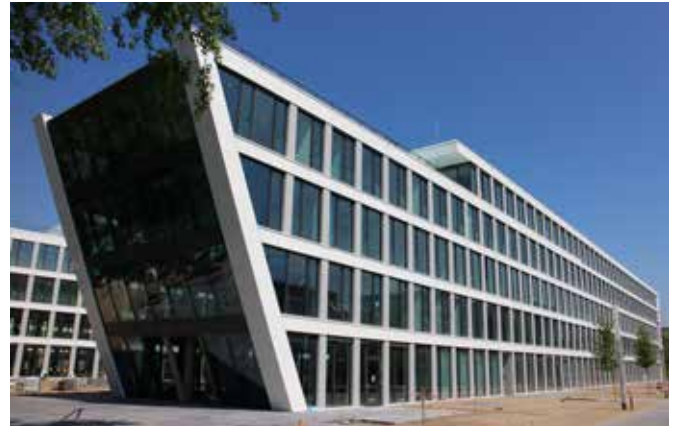
Bonner Bogen - Tyskland - Clima Canal 4-rørs
