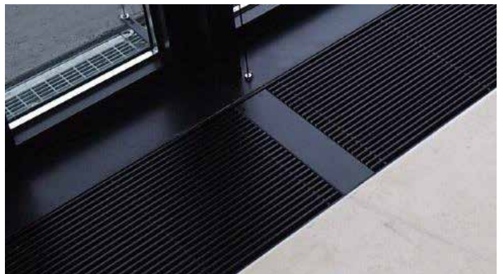
Mini Canal zwischenfüllplatte mit Isolation Santander Bank - Mönchengladbach
