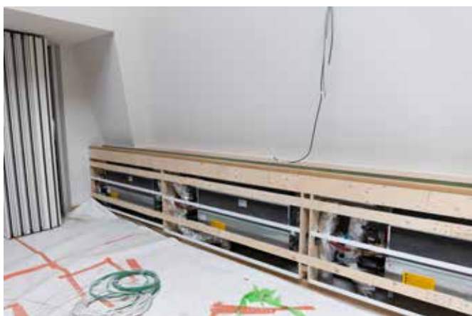
Vestavba do stěny
