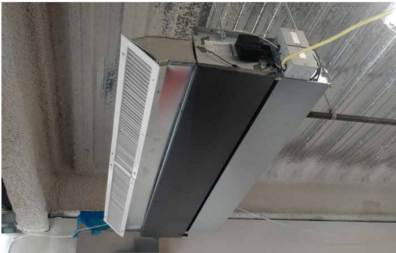
Vestavba do stropu
