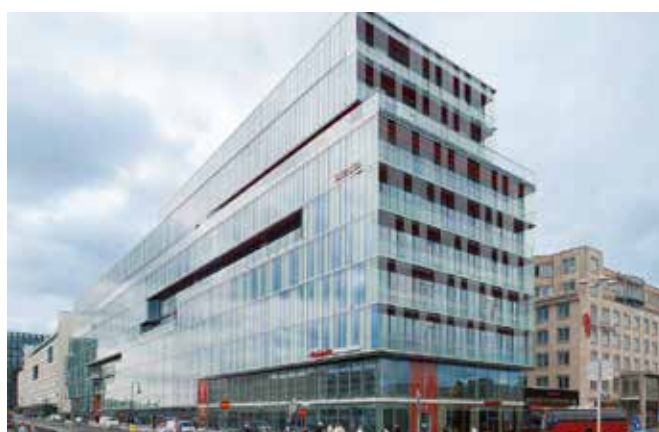
Kungsbrohuset - Švédsko - Mini Stojanový model & Strada
