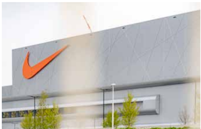
Nike Distributiecentrum - Belgien - AVS Luftheritzer
