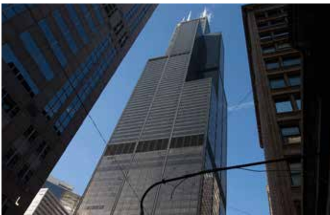
Willis Tower - USA - Clima Canal
