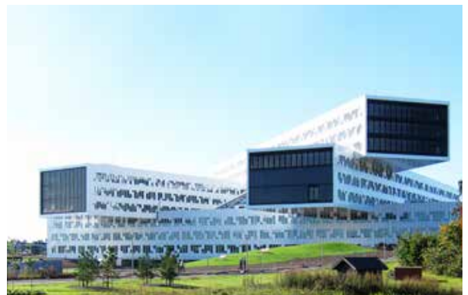
Statoil HQ - Norvège - Mini Canal
