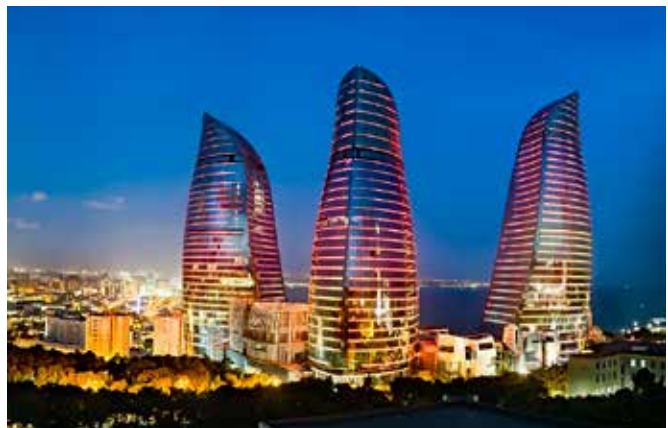
Flame Towers - Azerbaïdjan - Mini Canal
