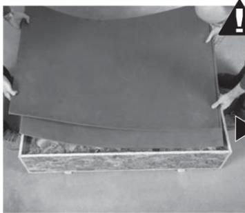
Gebruik het schuimrubber als bescherming op de vloer tijdens de montage van de Heatwave.
